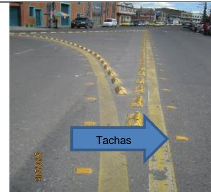
**Foto 19 y 20.** Tipo de señal horizontal. Detalle de marcas viales como tachones, tachas, líneas centrales y flechas direccionales. La pintura aplicada de metilmetacrilato presenta un alto grado de deterioro.
