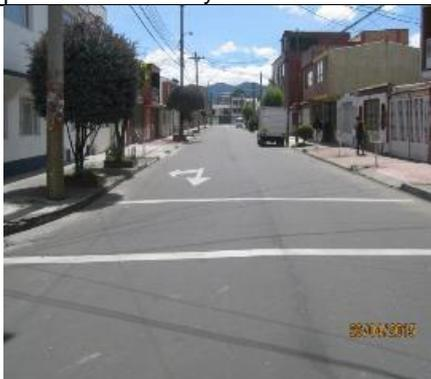
**Foto 18.** Tipos de señal horizontal, la pintura de metilmetacrilato se encuentra en buenas condiciones.
