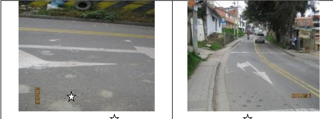
**Foto 7 y 8.** Tipos de señal horizontal, la pintura de metilmetacrilato con fecha de instalación de junio de 2014. La pintura se encuentra opaca y presenta un alto grado de desgaste. Los reductores de velocidad tipo estoperoles que fueron instalados en el momento de la visita no se encontraron.
