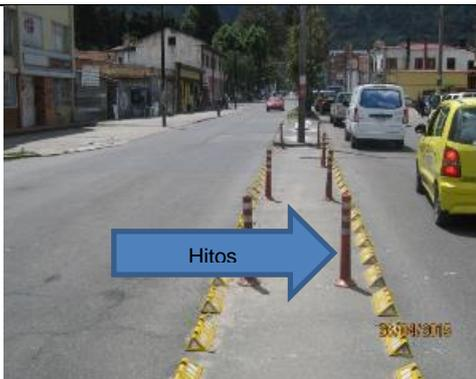
**Foto 17.** Tipo de señal horizontal presenta, demarcación vehicular con tachones e hitos, se encuentran en buenas condiciones
