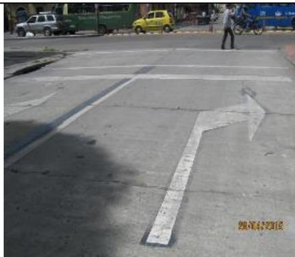
**Foto 16.** Tipo de señal horizontal, flechas direccionales, presenta desgaste por las condiciones del pavimento rígido. Implementado en mayo del 2014.
