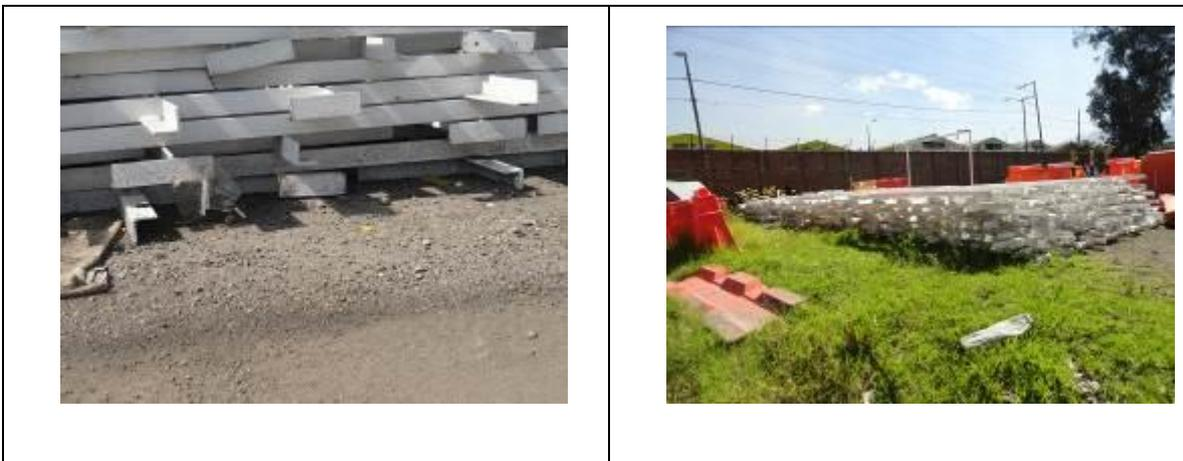
Los pedestales adecuados bajo la ejecución del contrato 2013-2076 no se encuentran correctamente almacenados en el Patio, toda vez que los mismos no están depositados sobre una estructura que permita protegerlos de las condiciones del terreno, disminuyendo su vida útil.
